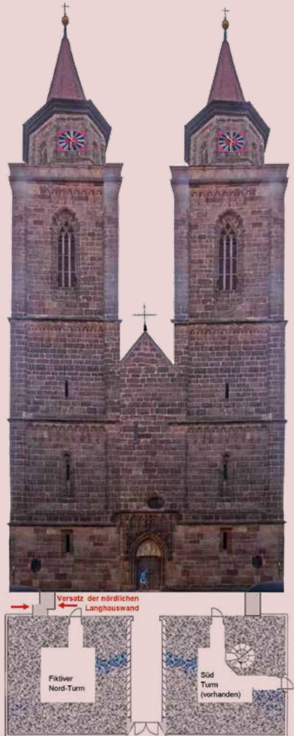
Abb. 2: Doppelturm-Anlage (Fotomontage) Der von Süd nach Nord gespiegelte Turm weist mit seinem Anschluss an die Langhauswand einen Versatz in halber Wandstärke auf. (rote Pfeile)
