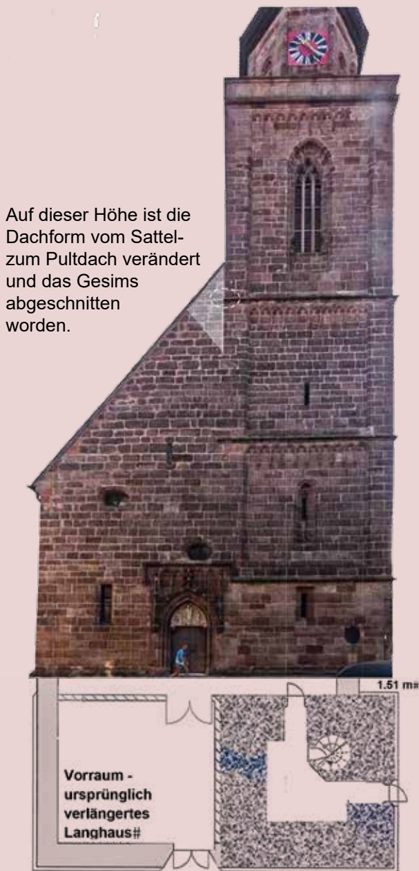
Abb. 1: Turmfassade von St. Michael
