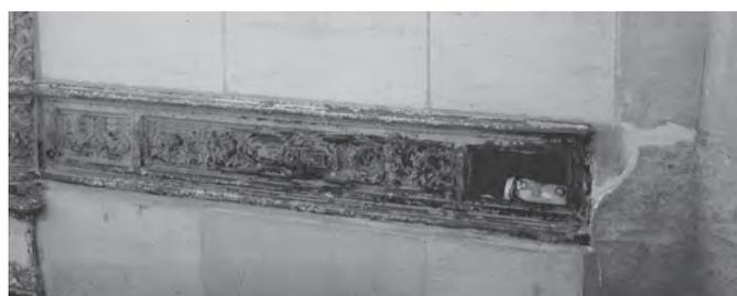
Königstr. 95, Flurstück 314: Rückseitiger Ladeneingang zugemauert, Gussäulen nur halb sichtbar, Hohlraum hinter fehlender Gussplatte wird als Mülleimer missbraucht.
