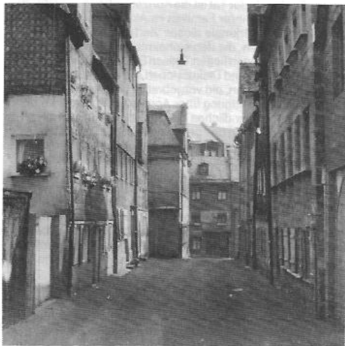
Schindelgasse – immer noch asphaltgeschädigt
